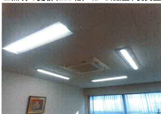
■照明の更新(LED化) 第2会議室、役員室
