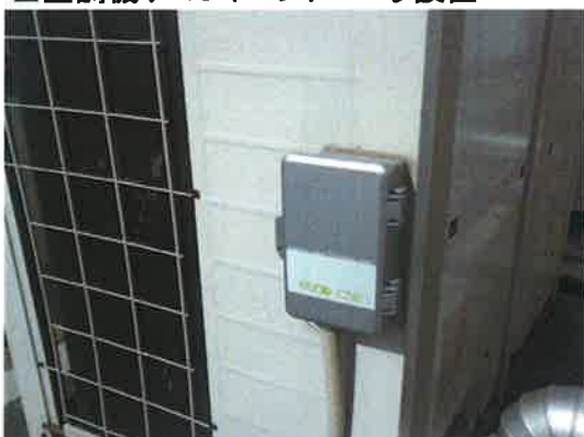
■空調機デマンドコントローラ設置
