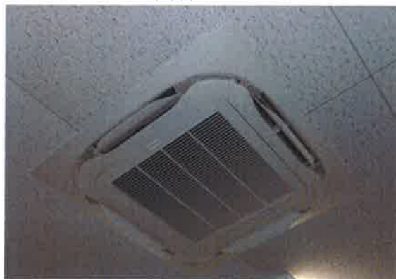
■事務所空調の更新
